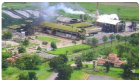
Usina Estreliana agora é Cooafsul
